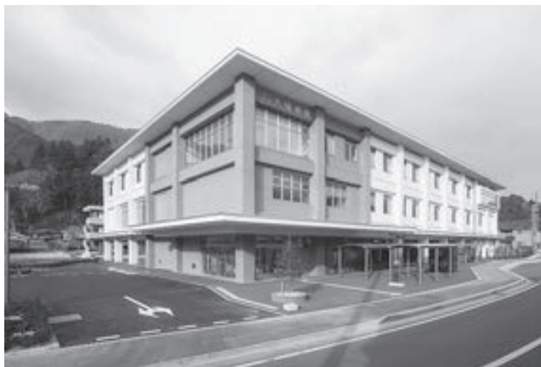
平成28年5月に開院した県立大槌病院
