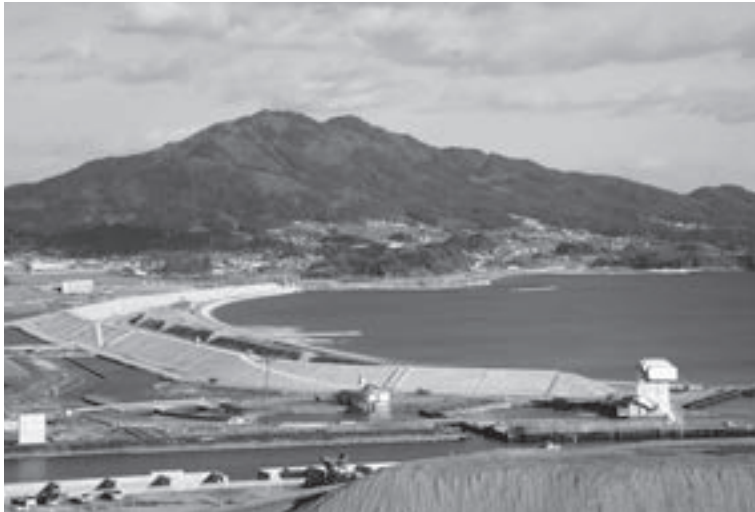
平成28年12月に完成した高田海岸防潮堤
