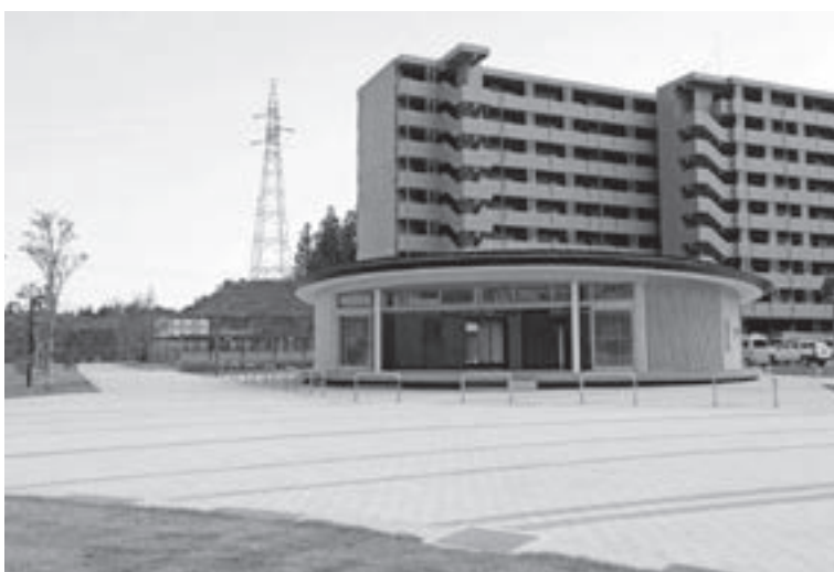
平成28年6月に完成した栃ヶ沢災害公営住宅 (RC造9階 301戸)
