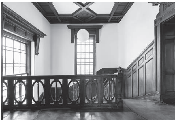
2階階段の欄干
