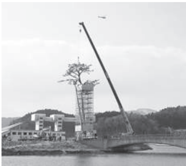
一本松の修復工事
